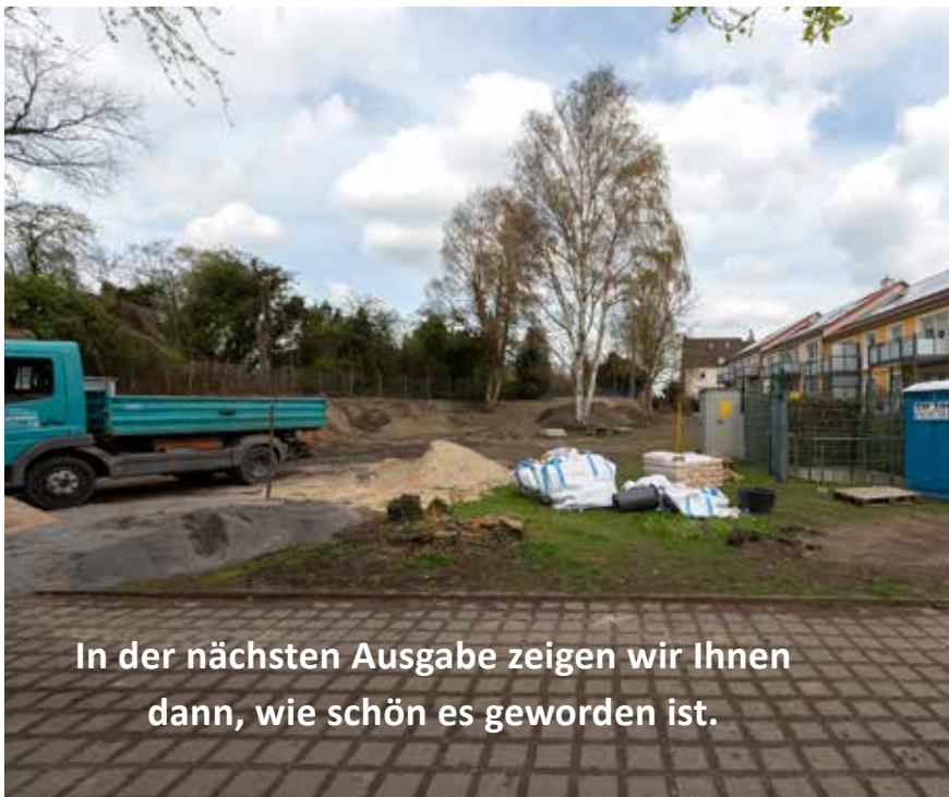
Der Wildwuchs ist abgerodet, bald wird gepflanzt.
