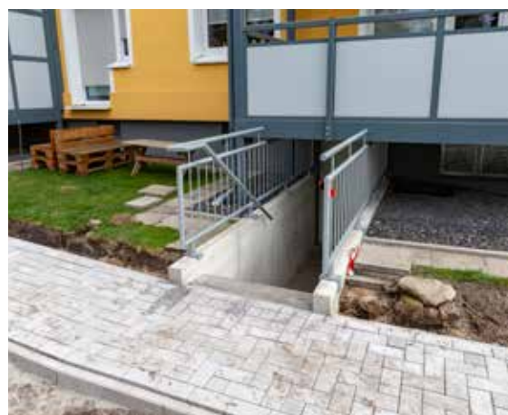
Die Arbeiten an den Außenanlagen sind in vollem Gange.
